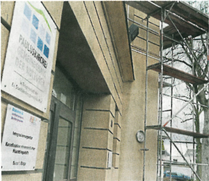
Ein Baugerüst umspannt das Gemeindehaus der Pauluskirche.
