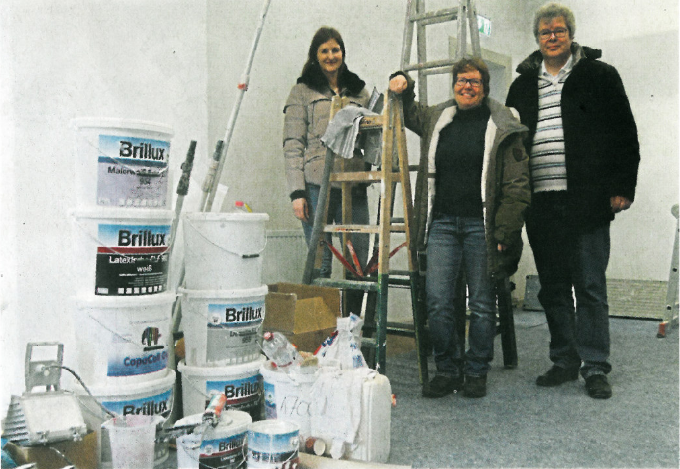
Das Gemeindehaus der Pauluskirche wird komplett auf Vordermann gebracht. Die Arbeiten laufen dort auf Hochtouren. Zur Baubegehung trafen sich jetzt Pfarrerin Daniela Kirschkowski (M.) und Pfarrer Roland Wanke mit Caroline Orlob vom Architekturbüro Steinke + Zils. —FOTOS: CLAUS PAWLINKA
